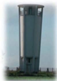
cheminée à Pleumeleuc
