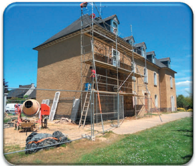
Pose de l'enduit d'accroche
